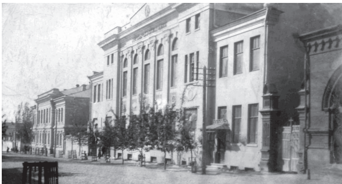
Здание Сталинградской областной конторы Госбанка СССР (ул. Володарского, 7). Фото 1930-х годов
